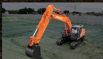
位置情報により掘削面を認識
