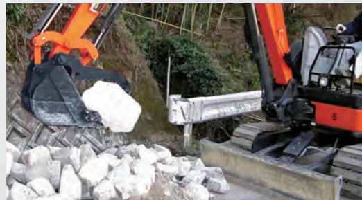
瓦礫や石の除去にも
