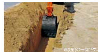
溝掘削の一例です。
