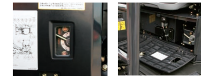
確認が容易な点検窓
