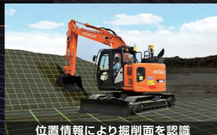
位置情報により掘削面を認識
