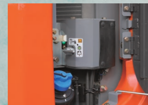
バッテリーディスコネクトスイッチ (車体左側)
