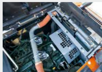
ラジエータ清掃窓
