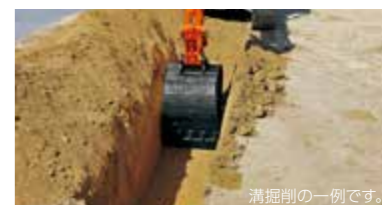
溝掘削の一例です。
