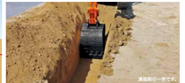
溝掘削の一例です。
